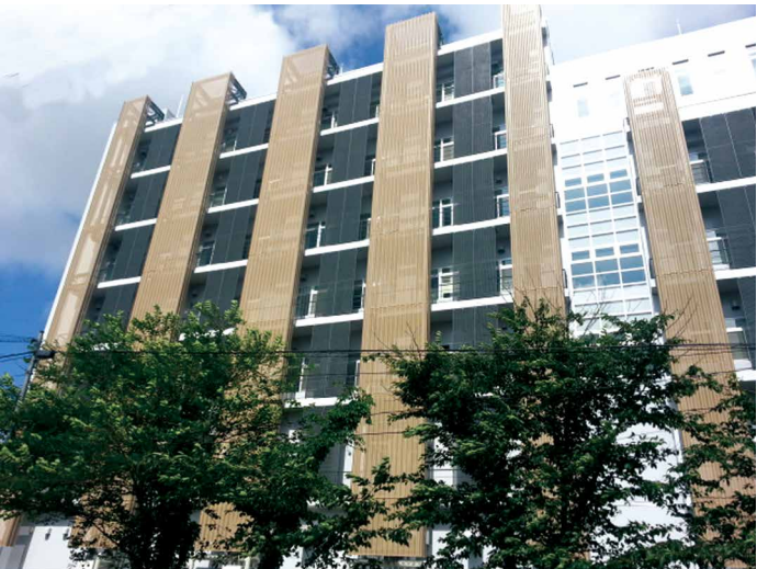
建物外壁の化粧、目隠しとして
