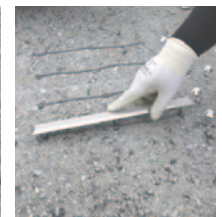
4. 鉾を埋め込み、鉾と床面に隙間がないか、平らに固定されているかを確認する。
