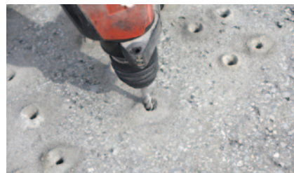
1. 警告鉾はφ8.5~φ9mm、誘導用はφ9~φ10mmの下穴をあける。
