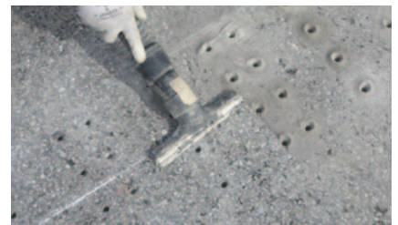
2. 穴あけ後、穴の中の石粉等を掃除機で吸引除去する。
