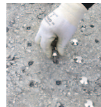
4. 鉾を埋め込み、鉾と床面に隙間がないか、平らに固定されているかを確認する。
