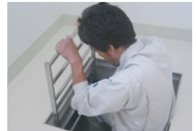
ビット内に昇降用タラップを 追加で設置することをお勧めいたします。
