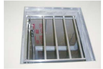
床点検口の蓋が開いていても、 格子により転落を防止できます。
