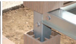
鋼材を芯材にした支柱
