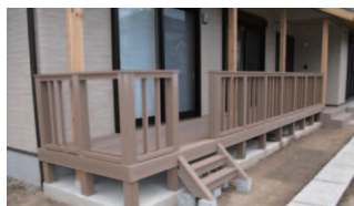
コンクリート下地を基礎に
