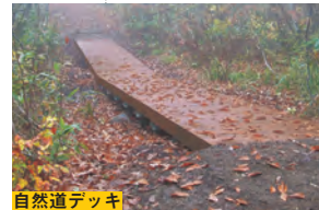
自然道デッキ
