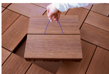
STEP 1 外周から設置し、順々に中を設置します。
