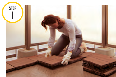
STEP 1 外周から設置し、順々に中を設置します。
