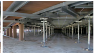
鋼製束を用いた例
