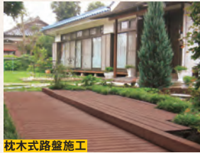
枕木式路盤施工
