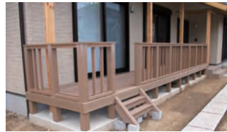
コンクリート下地を基礎に
