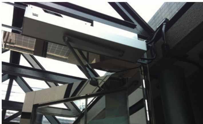
マンション出入口
